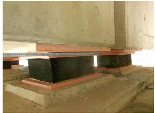
이동량 측정 작업전경
